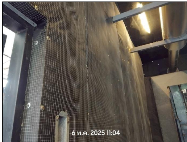
รูปที่ 2.35 แผ่นป้องกันเสียงภายในห้องกำเนิดไฟฟ้าฉุกเฉิน
