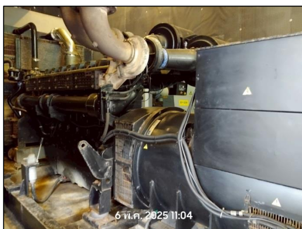
รูปที่ 2.3 เครื่องกำเนิดไฟฟ้า และถังเก็บน้ำมันสำรอง
